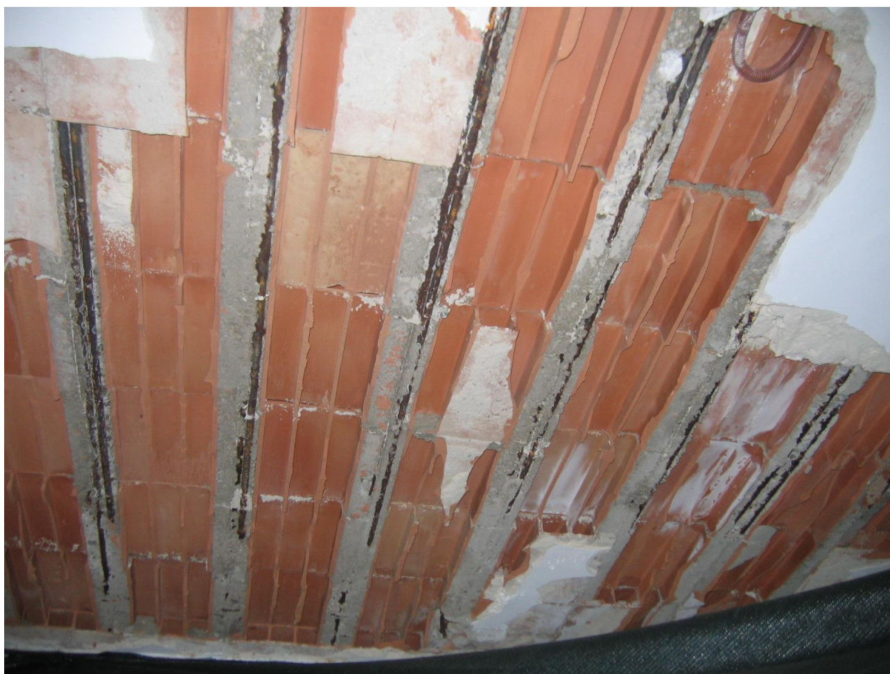
Fig. 20 – Particolare saggio n. 7 soffitto solaio di collegamento ballatoi - P1.
