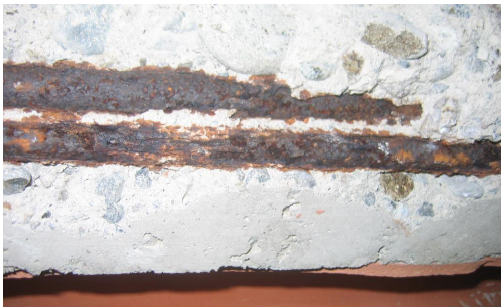
Fig. 15 – Vista di un tratto di armatura dei travetti dei soffitti del Reparto.
