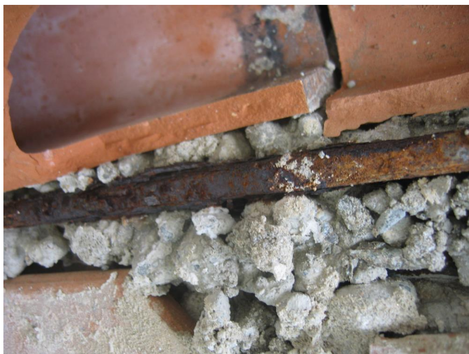
Fig. 16 – Particolare di un travetto in cui è possibile rilevare la segregazione degli inerti e l'ossidazione dell'armatura metallica.
