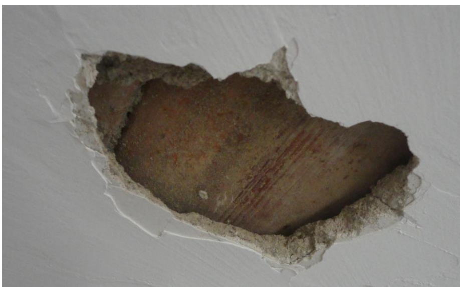
Fig. 18 – Particolare di intonaco distacco staccato dal supporto privo di rinzafo.
