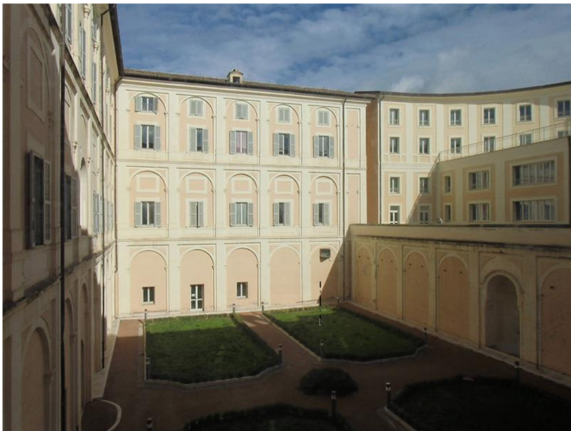
Cortile interno e ampliamento realizzato nel 2014 (lato destro)
