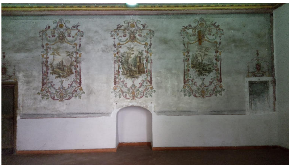
Napoli – Valorizzazione del patrimonio immobiliare dell'Archivio Notarile dopo il versamento delle Pandette del 1700-1800 all'Archivio di Stato. Prima e dopo l'intervento.
